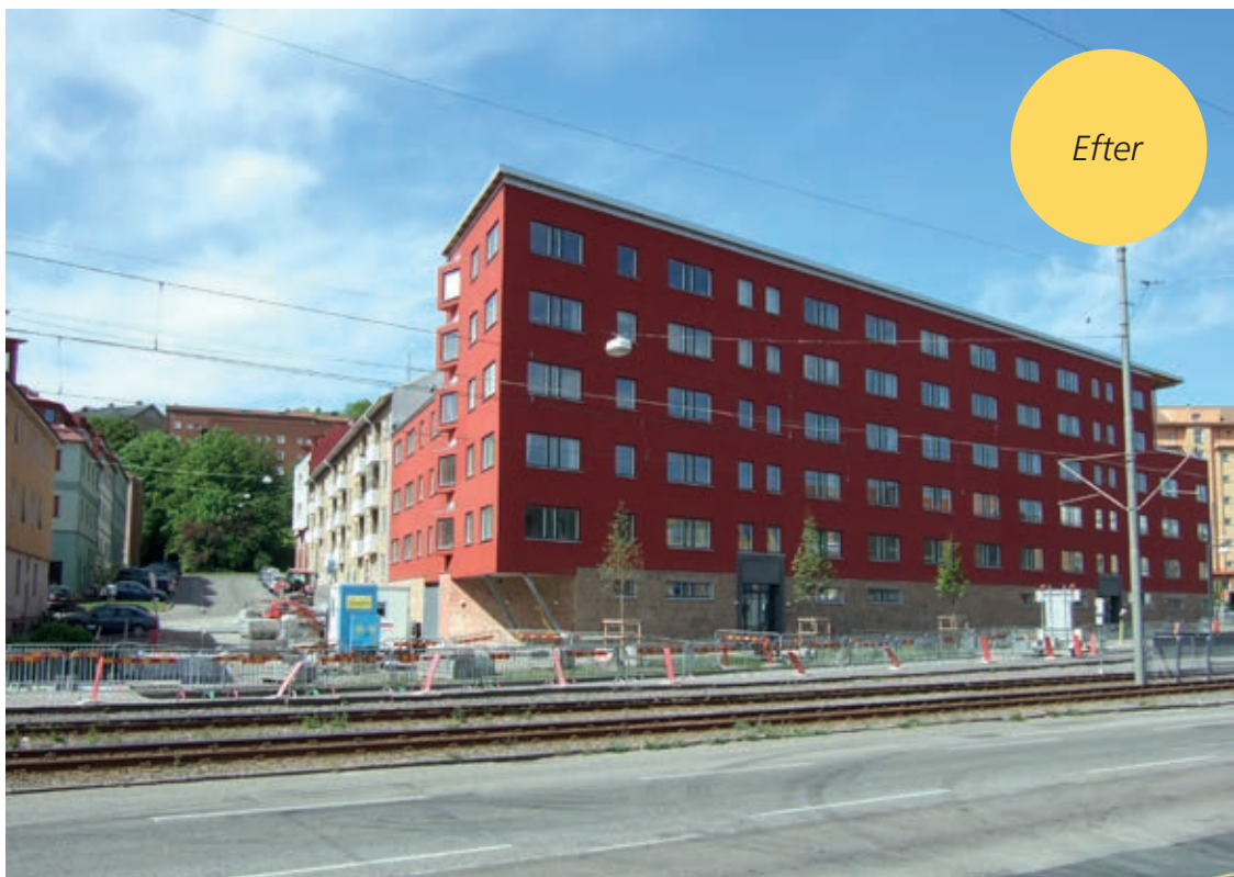
Figur 11. Kvarteret Örlen i Göteborg före och efter förtätning med en skärmande byggnad. Ljudnivån på gården minskade med 6-10 dBA och andelen störda av trafikbuller minskade från 45 procent till 25 procent efter uppförandet av den nya byggnaden [39]. Studien har gjorts inom programmet Ljudlandskap för bättre hälsa . Foto: Anita Gidlöf Gunnarsson.
